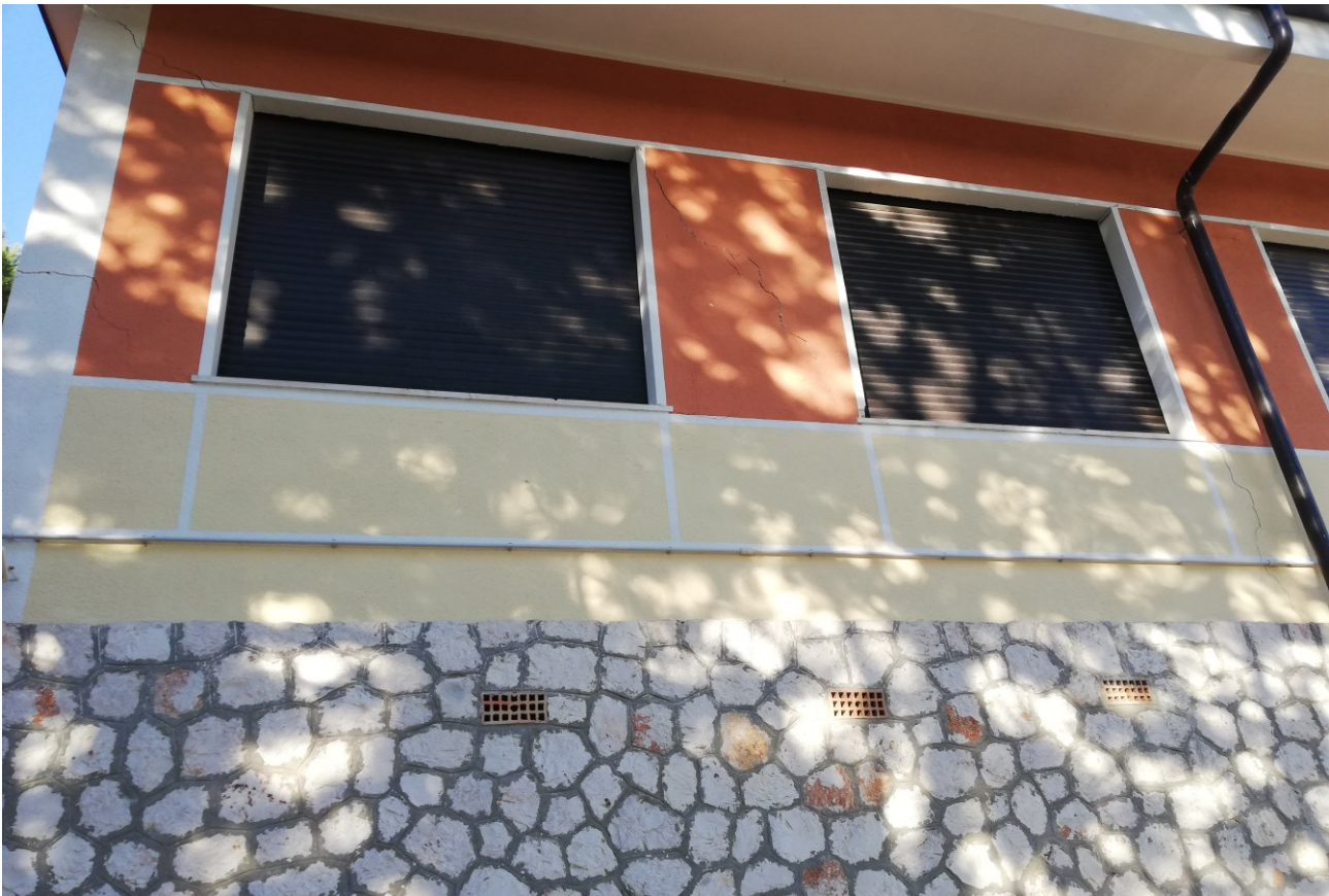
Fessurazione 1 sul lato esterno di valle dell'edificio
