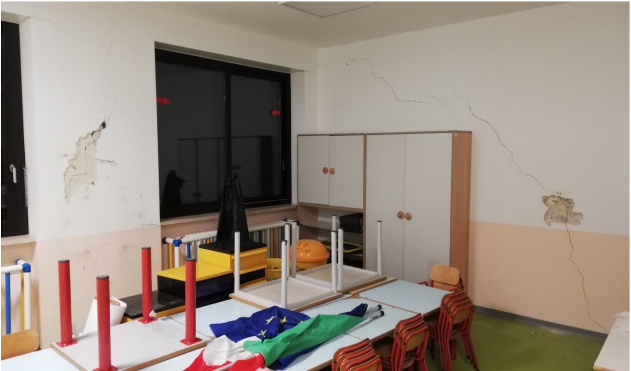
Fessurazioni 1 ( a sinistra) e 2 (a destra) nelle pareti dell'aula all'angolo sud – ovest dell'edificio
