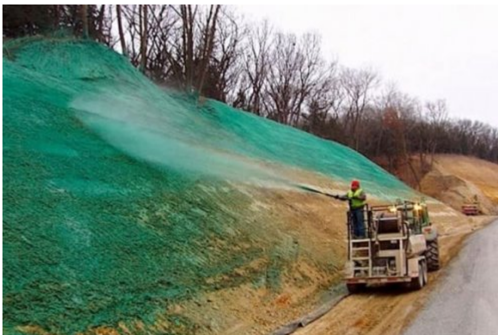
idrosemina (inerbimento scarpata)
